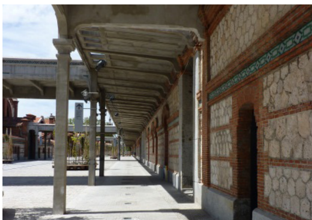
Imagen 1, Centro cultural Matadero, en Madrid. Reciclaje de lo que en un tiempo fue un rastro municipal de animales de Madrid.
