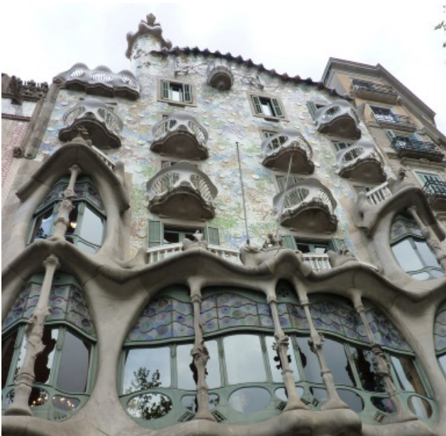
Imagen 8. Fachada de la casa Batlló; reconstruye la historia del inmueble y su función cotidiana.
