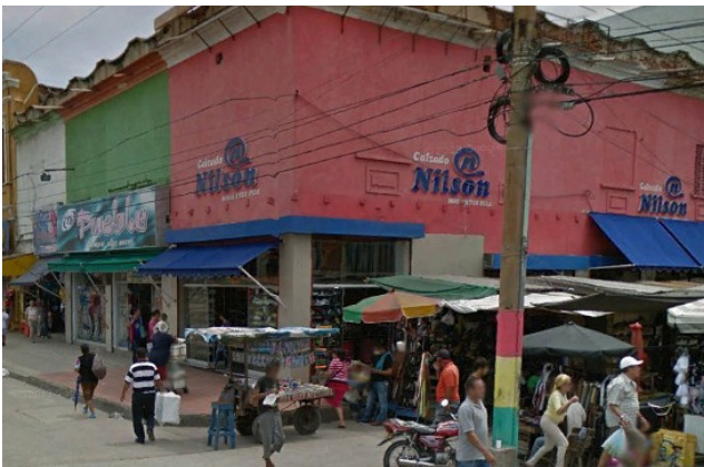
Imagen 26. Casa colonial de dos pisos ubicada en la calle 30 con carrera 41. Aún se observan los canes del balcón corrido por ambas caras de la fachada y los vanos clausurados del segundo piso.
