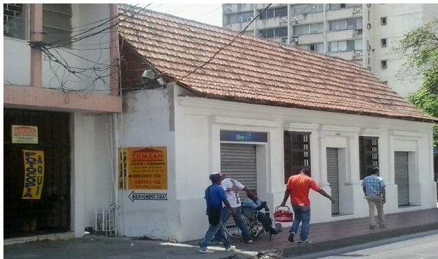
Imagen 8. Casa de esta tipología ubicada en la Calle de las Flores (Calle 40) entre Carreras 43 y 44. Nótese que las ventanas de las dos habitaciones ubicadas a lado y lado de la sala fueron remplazadas recientemente por puertas de estera para ser habilitadas como locales comerciales.
