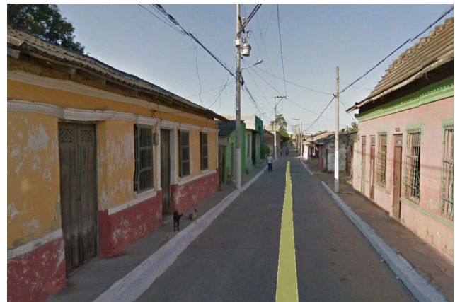
Imagen 12. Casas en la calle 29 con carrera 32. En el lado izquierdo se conserva en regular estado una vivienda de la tipología de dos habitaciones. El cambio notable está en la cubierta, la cual fue remplazada por láminas de eternit. Del lado derecho se observa una evolución de esta vivienda. Aunque conserva la tipología espacial (casa de dos habitaciones) y los aspectos formales (cubierta inclinada de dos aguas y cornisas), las paredes ya son de ladrillo y a las ventanas, en vez de guardapolvo en la parte superior, las enmarcan unas molduras y la caja de la ventana es una canasta de hierro.
