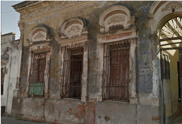
Imagen 32. Aunque tipológicamente estas viviendas corresponden a la organización espacial de las casas bajas, ya contienen elementos decorativos como molduras y capiteles de arquitectura neoclásica, muy frecuentes en el sector del barrio San Roque. Por la puerta, se alcanza a observar la estructura de madera de la cubierta plana sin los ladrillos y el pañete.
