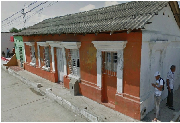
Imagen 11. Casa de dos habitaciones con corredor esquinera ubicada en la calle 28 del barrio Rebolo. Nótese que el vano de la esquina fue clausurado pero aún sobresale la portada. La cubierta, que en la evolución de materiales pasó de la palma a la teja de cemento fue remplazada por láminas de asbesto cemento. (Fuente: Google Earth)
