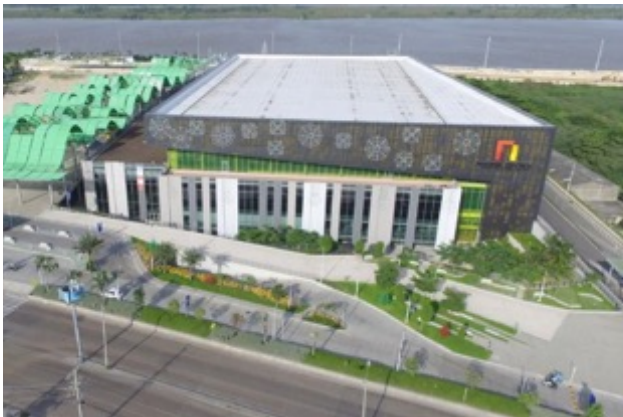
Ilustración 5 Centro de Eventos Puerta de Oro.
