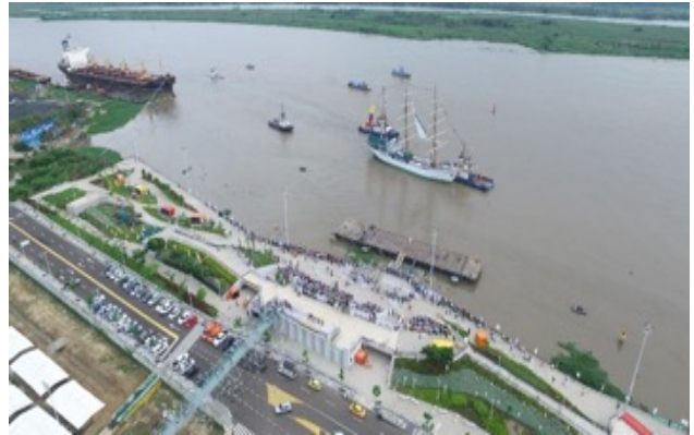
Ilustración 6 Gran Malecón del Río, tramo Centro de Eventos Puerta de Oro.
