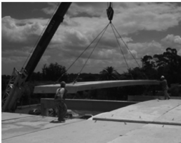
Figura 12. Transporte y montaje de elementos de prefabricación pesada.
